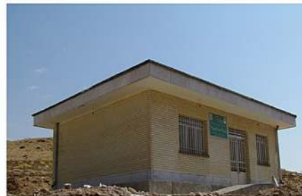
خانه بهداشت امام سجاد (ع) روستای صالحات احداث: ۱۳۹۰
