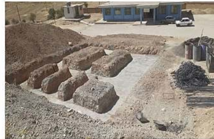
خانه بهداشت اسلام آباد به همت بنیاد نیکوکاران مفید احداث: ۱۴۰۵
