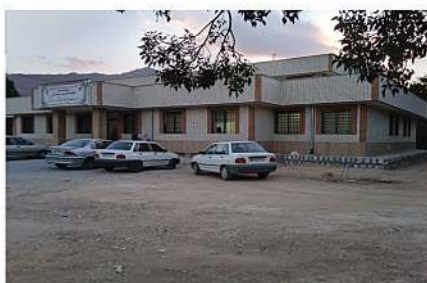
مرکز خدمات جامع سلامت شبانه روزی و ۲ باب خانه پزشک - روستای دزک احداث : ۱۳۹۷
