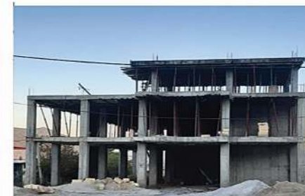
مرکز خدمات جامع سلامت و مرکز مشاوره قبل ازدواج کوهرنگ - احداث: ۱۴۰۴
