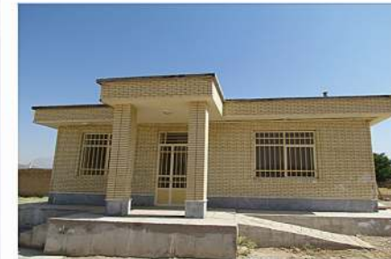
خانه بهداشت روستای گرداب سفلی احداث: ۱۳۹۳
