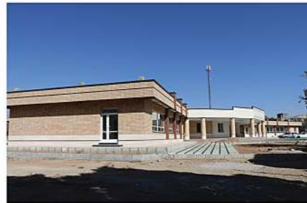
مرکز خدمات جامع سلامت شبانه روزی و کلینیک تخصصی شهدای صنعت هفشجان - احداث ۱۳۹۷
