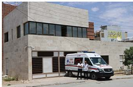
پایگاه اورژانس و فوریت های پزشکی امام سجاد (ع) بروجن - احداث: ۱۳۹۷
