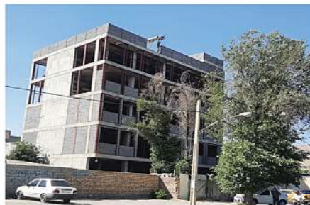
مرکز خدمات جامع سلامت و کلینیک دندانپزشکی محله بوعلی سینا شهرکرد - احداث ۱۴۰۳
