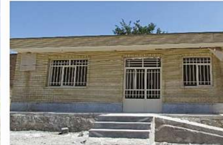
خانه بهداشت شهید قاسم مختاری روستای دهنونده - احداث : ۱۳۹۰
