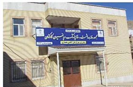
مجموعه خانه های پزشک، بهداشت، سرباداری و بانسیون کارکنان چراغ خان الیاسی بختیاری - دشتک احداث : ۱۳۹۳
